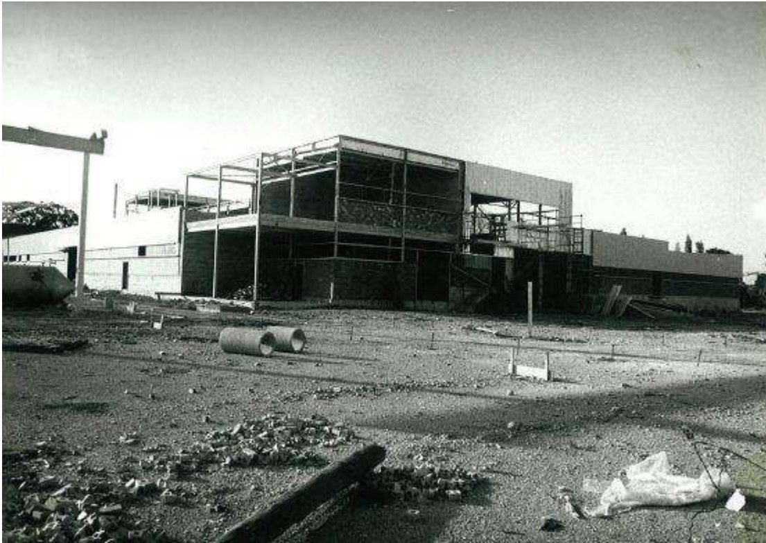
Imagen 6. Empresa Lascaray en construcción
